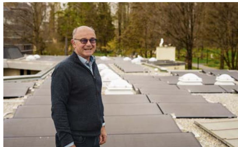
R. Steinmann, Photovoltaikanlage, Pfarreizentrum Hünenberg.
